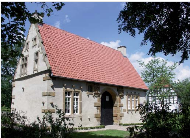
Das Werburger Torhaus in Spenge beherbergt das Standesamt. Es wurde gerade von Grund auf renoviert.
